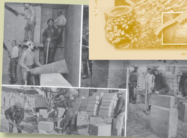
AFBEELDING 1 Verschillende aspecten van de mergelontginning. Het blokkeken is de onderkade groeve, het sorteerwiel met meerpomp in de bakken en het op maat malen van de blokken. (Compositie van foto's uit Van Mergelgroeve tot Bouwwerk in Limburg ◀ in beeld, 6 februari 1932.)
